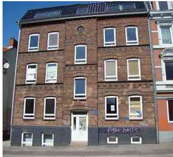
Unbewohnbar zugerichtetes Haus in der Preetzer Straße 11a
