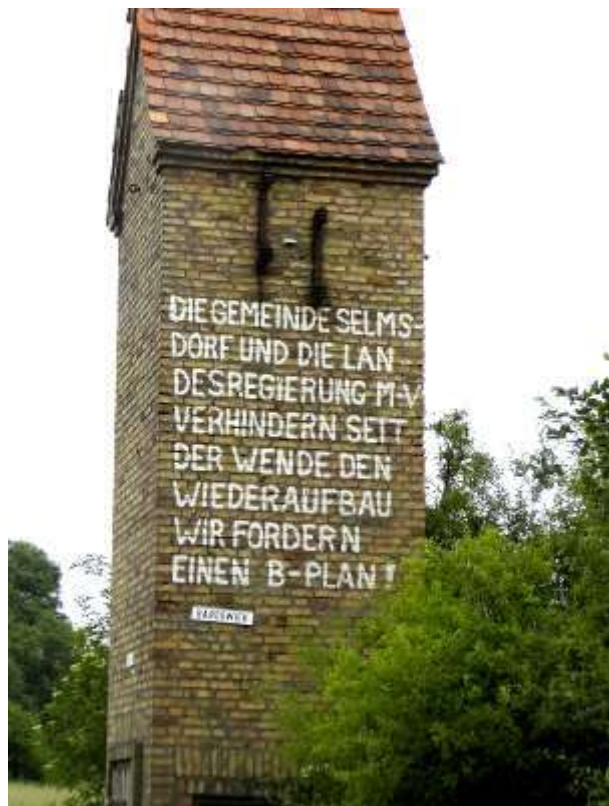
In der Gegenrichtung ist zu lesen: „Die Gemeinde Selmsdorf und die Landesregierung M-V verhindern seit der Wende den Wiederaufbau. Wir fordern einen B-Plan !“
